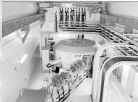
サイクロトロン (国立がん研究センター東病院)
