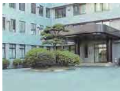
電力システム製作所
