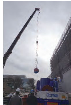
重機吊り器で吊り上げ、電動台車で運び出し、クレーンでトラックに積み込みます。新線源装填後は逆の手順で搬入します。
